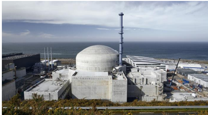
EPR presso la centrale nucleare di Flamanville (Francia). Photo courtesy EDF Médiathèque
